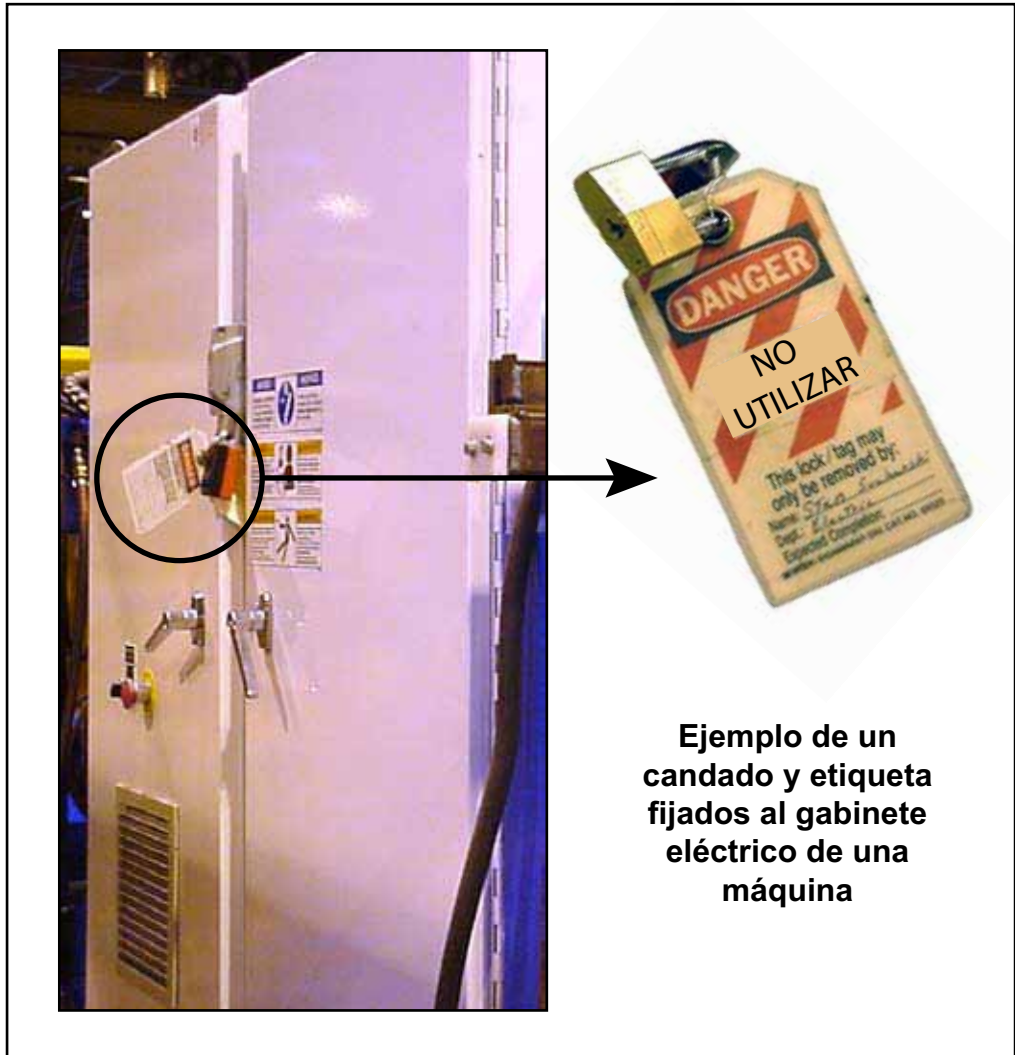
Figura SEGURIDAD-1: Ejemplo de un mecanismo de Bloqueo/Etiquetas en un gabinete eléctrico
